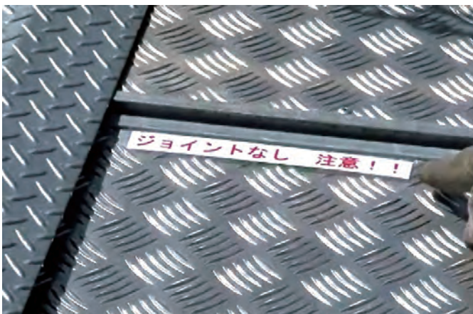
◀ ジョイントを取り外した場所での例
